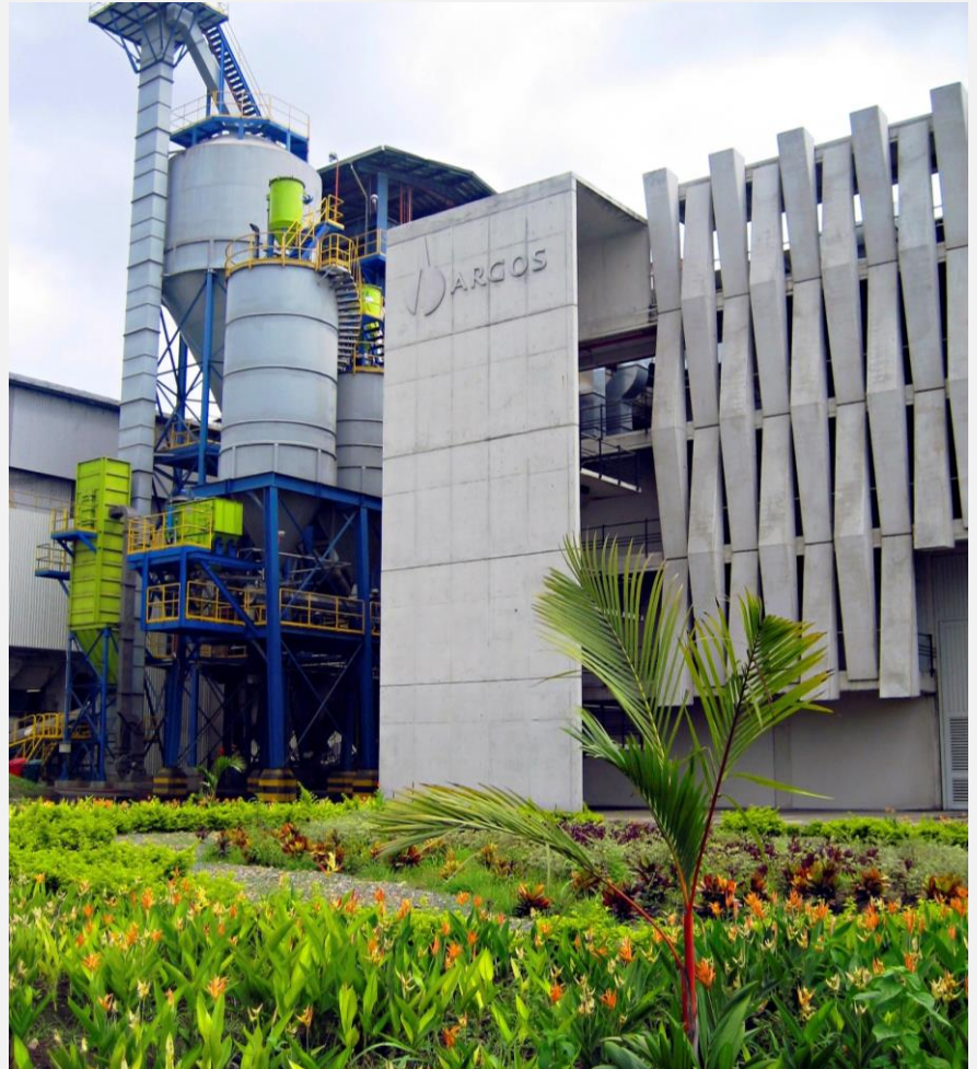
Planta de cemento, Yumbo, Colombia
