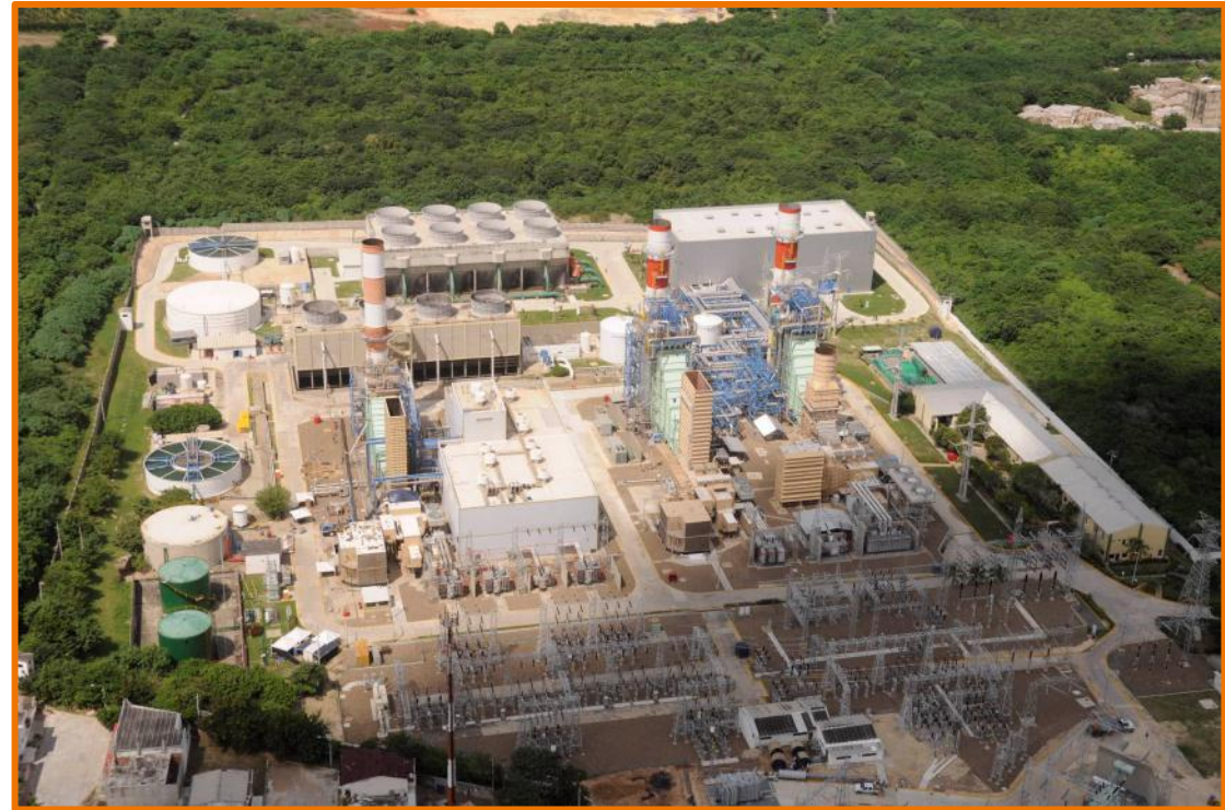
Planta de generación Zona Franca Barranquilla
