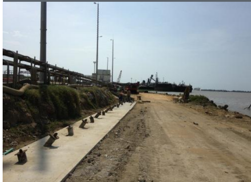
Adecuación muelle en Barranquilla
