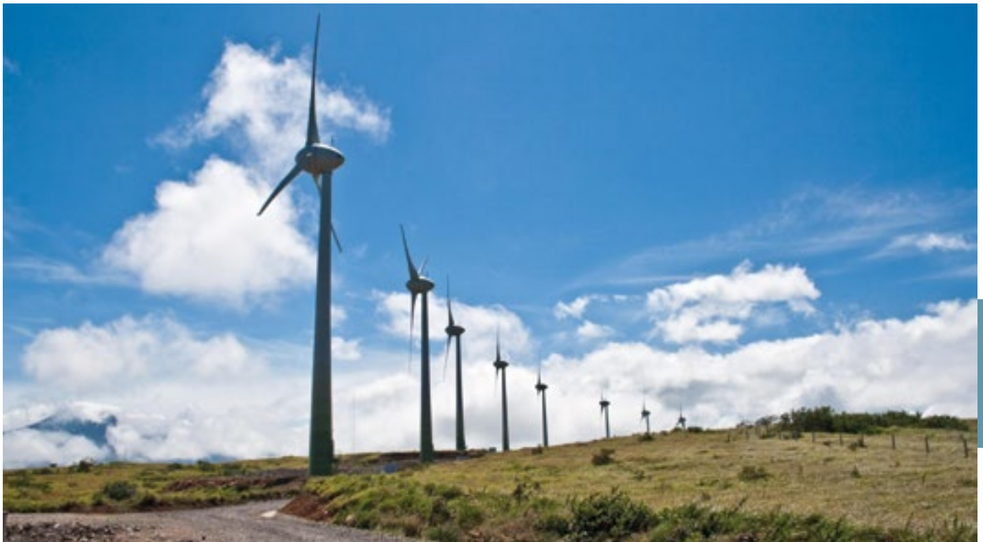
Parque de energía eólica en Guanacaste, Costa Rica. Celsia.
