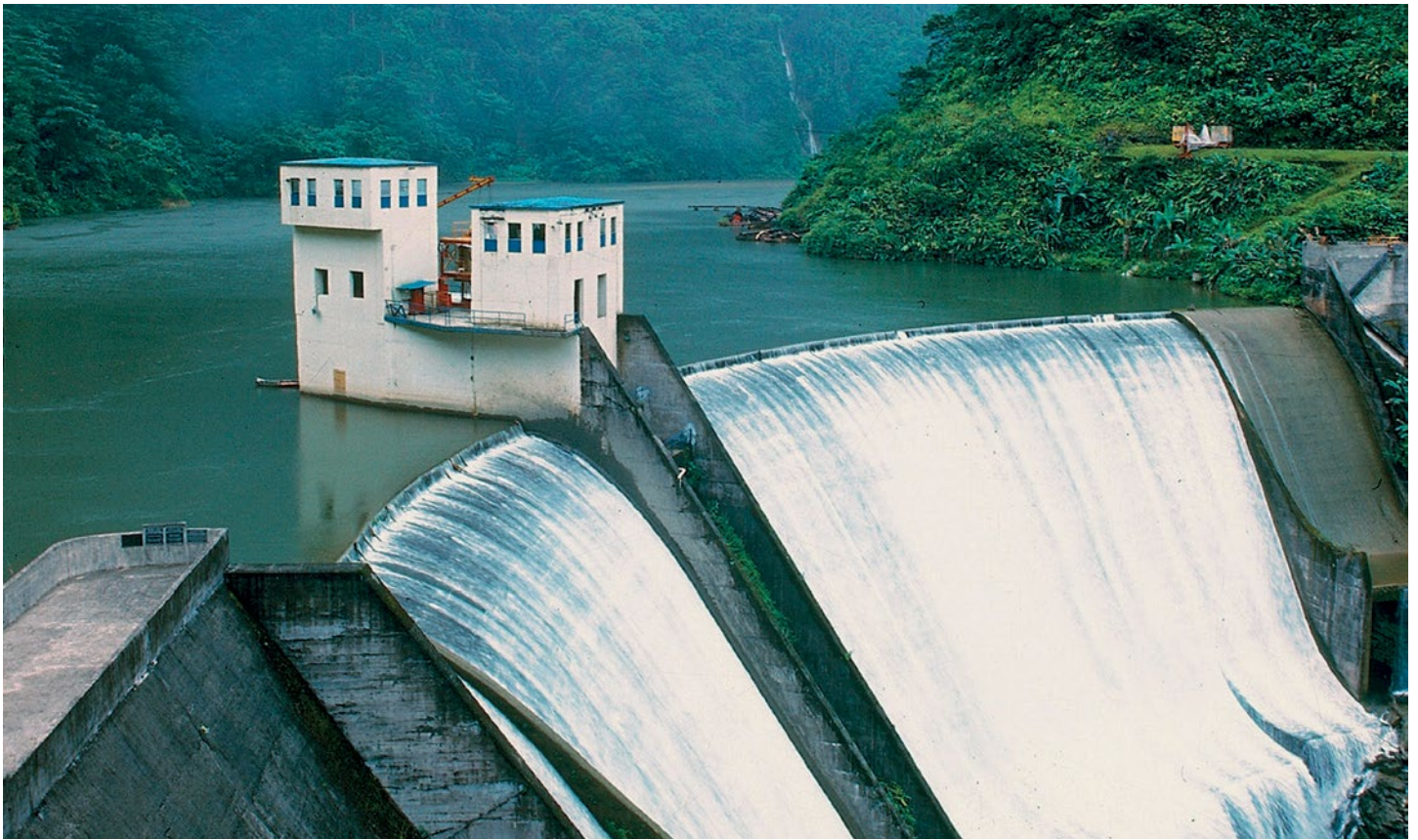
Central hidroeléctrica Bajo Anchicayá de Celsia en Valle del Cauca.
