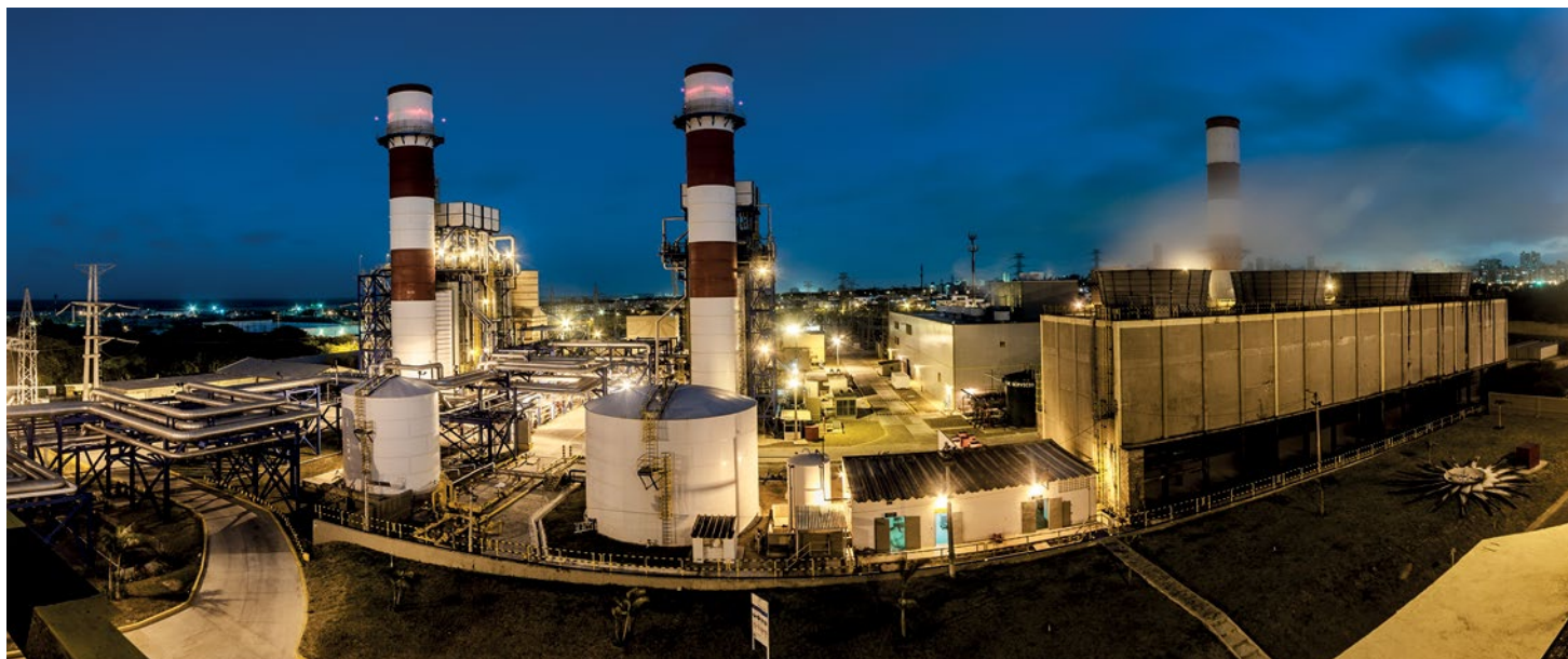
Central termoeléctrica Zona Franca, Celsia en Barranquilla.
