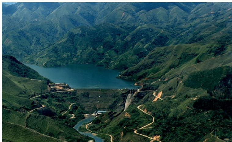
Central hidroeléctrica Salvajina, Suárez, Cauca.
