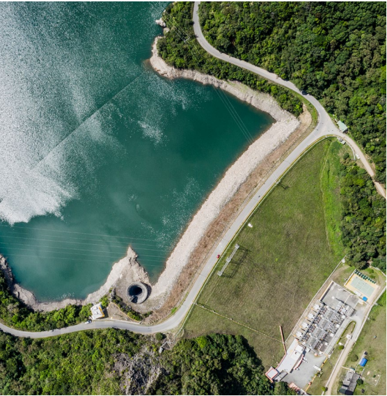
Celsia Hidroeléctrica Calima Valle del Cauca
