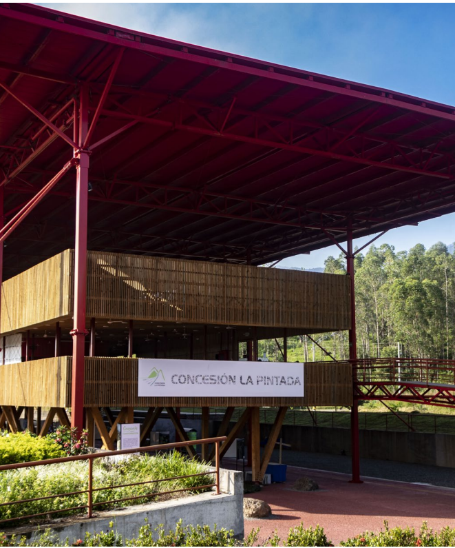
Centro de Control de Operaciones Pacífico 2 Antioquia
