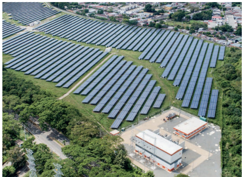
Subestación Espinal y Celsia Solar Espinal Tolima
