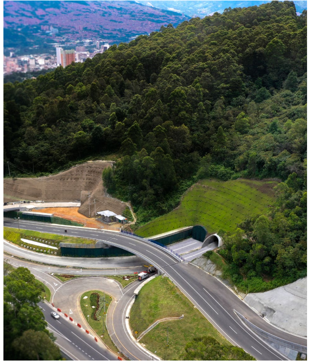
Túnel de Oriente Antioquia
