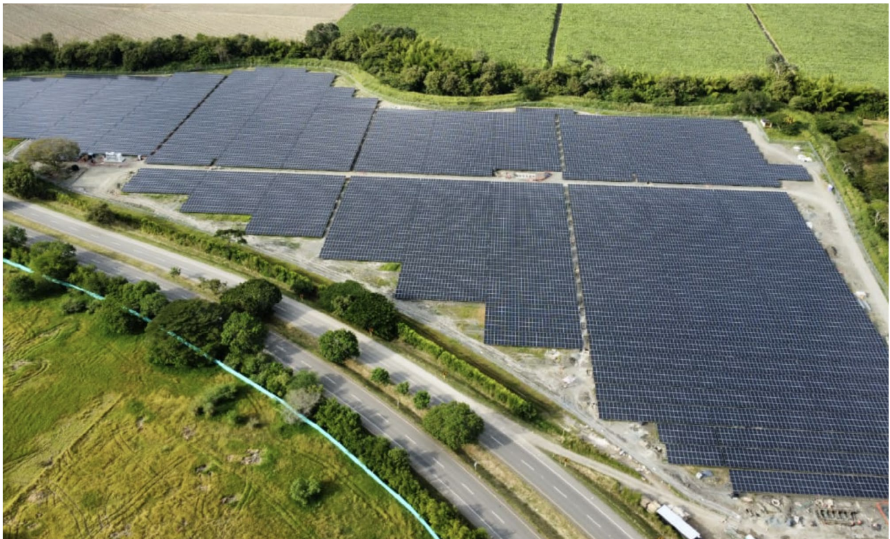
Celsia Solar Palmira III Valle del Cauca
