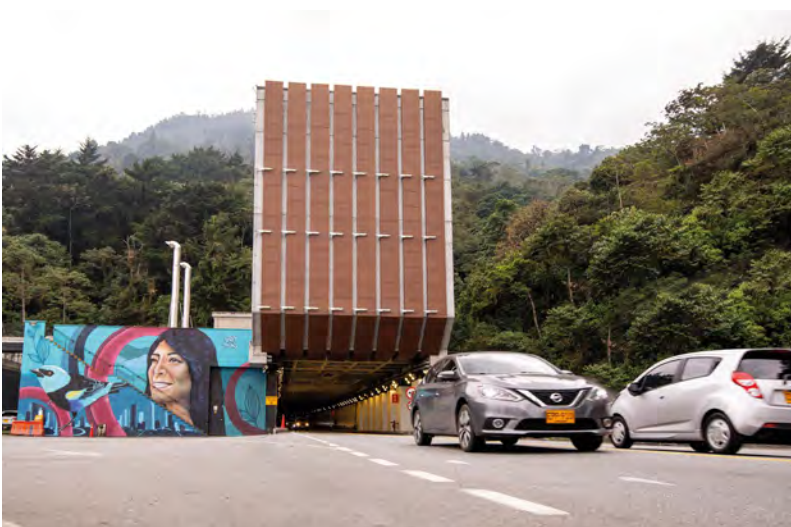
Túnel de Oriente Antioquia
