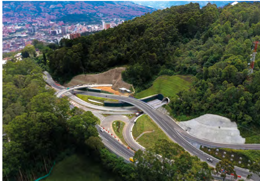
Túnel de Oriente Antioquia
