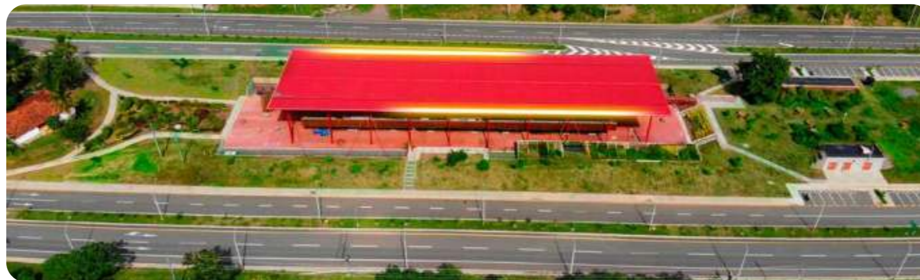
Plaza del Cauca » Conexión Pacífico 2
