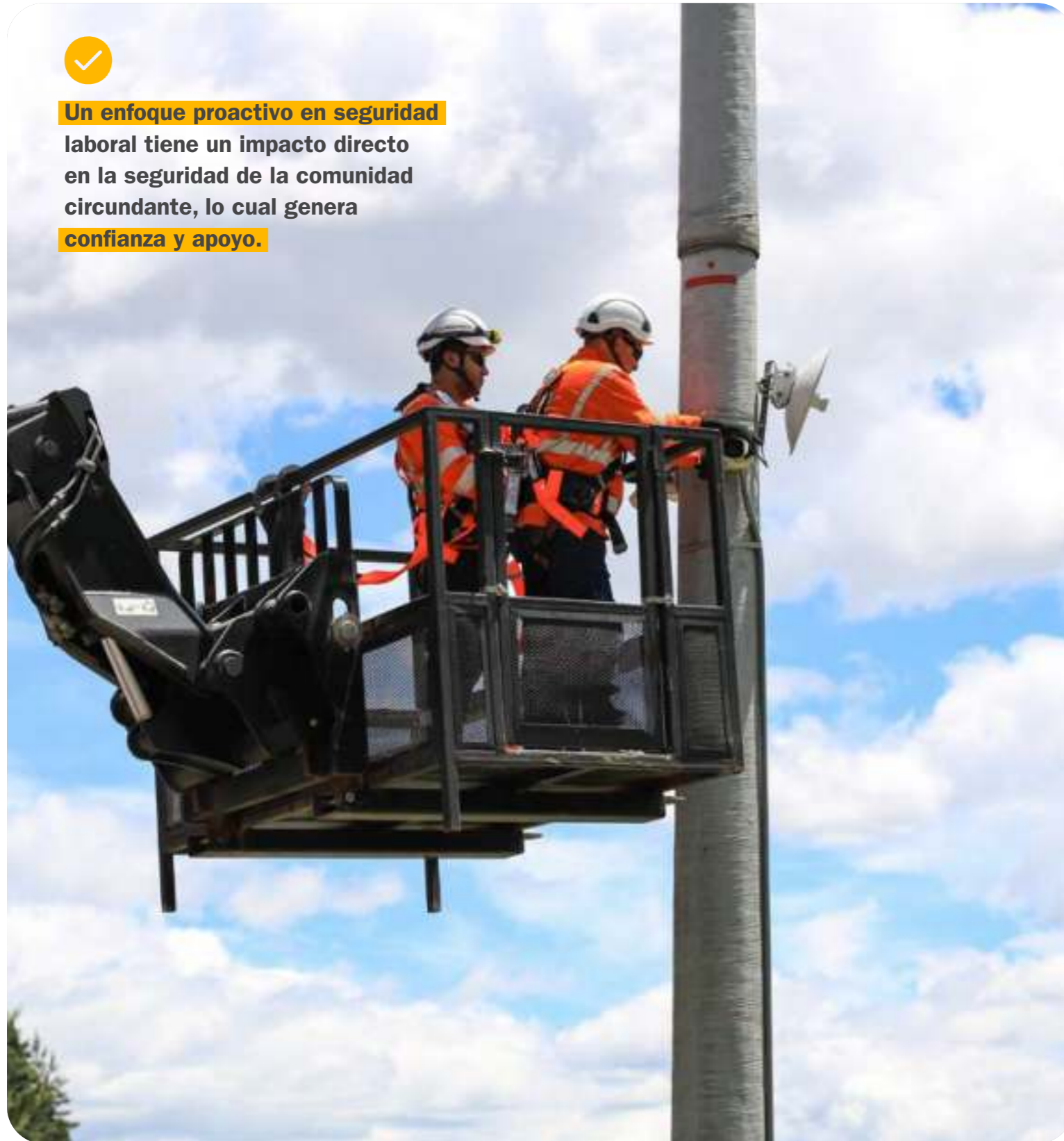
Labores de mantenimiento a la infraestructura vial
