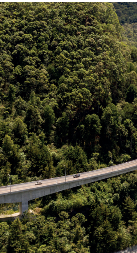
Túnel de Oriente Antioquia
