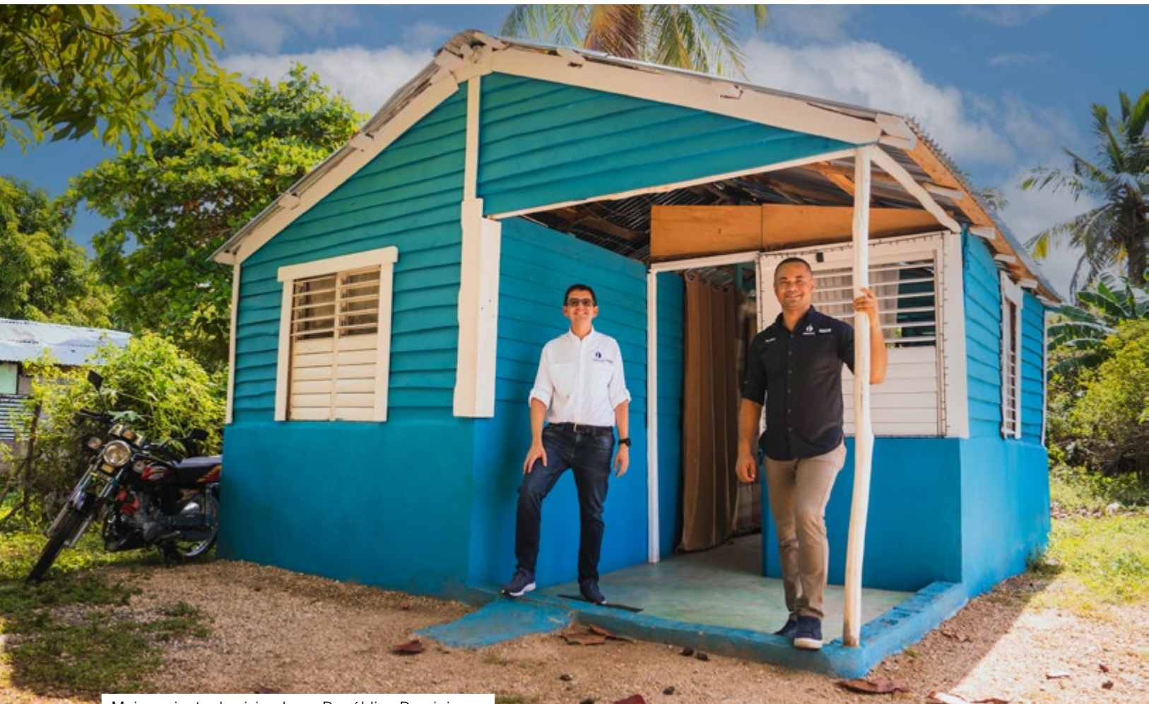
Mejoramiento de vivienda en República Dominicana
