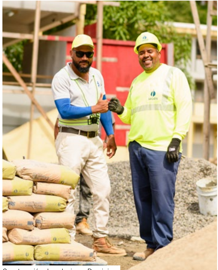
Construcción de colegio en Dominica
