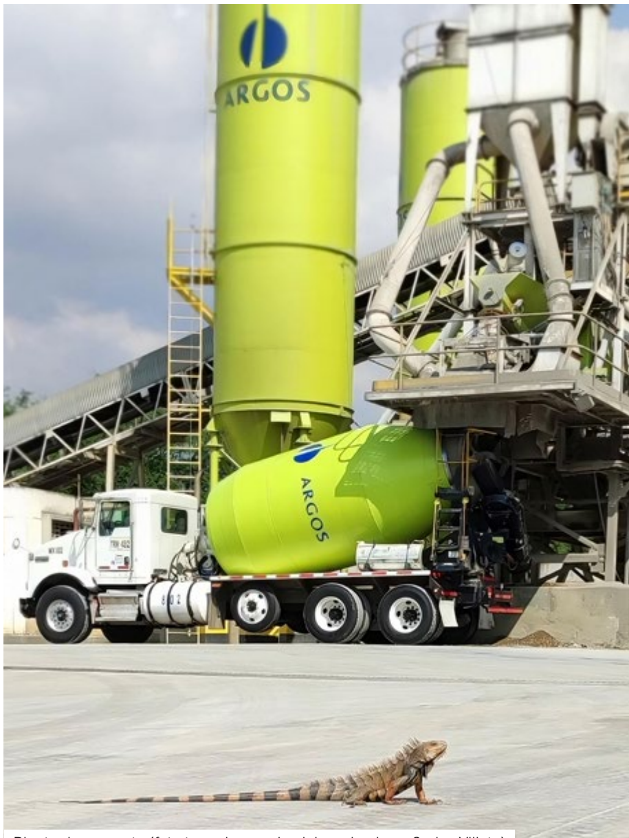
Planta de concreto (foto tomada por el colaborador Juan Carlos Villota)
