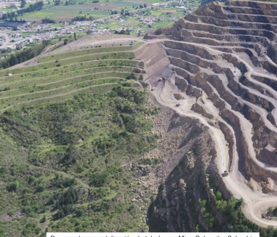
Proceso de revegetalización de taludes en Mina Belencito, Colombia
