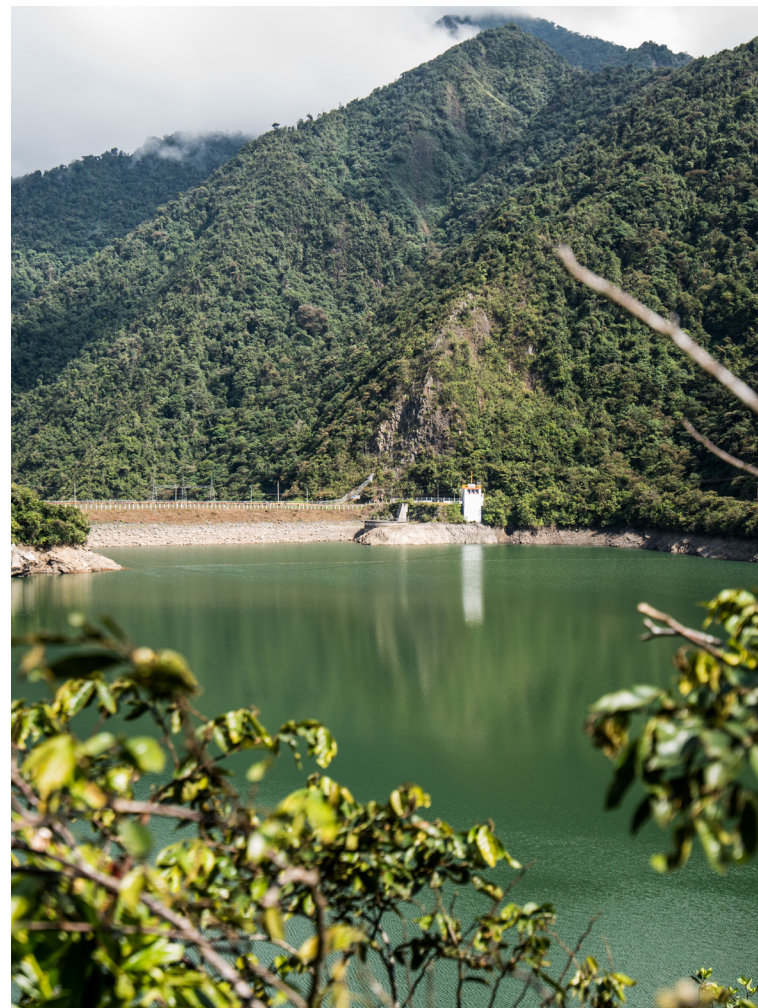
Central Hidroeléctrica Calima Valle del Cauca
