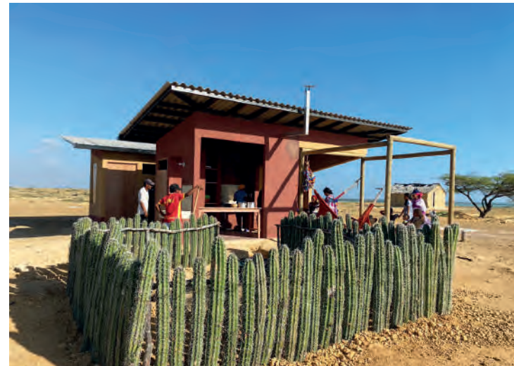
Vivienda entregada a la comunidad, La Guajira.
