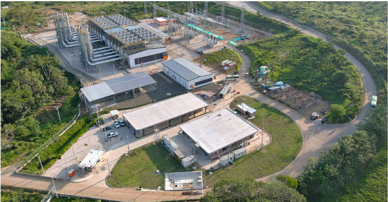
Central térmica Tesorito Córdoba
