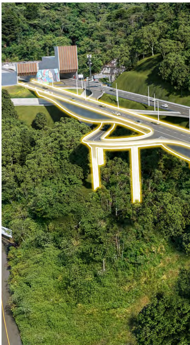
Túnel de Oriente Antioquia
