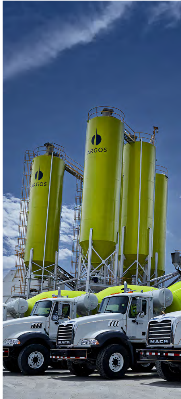
Planta Concreto Cementos Argos Bogotá
