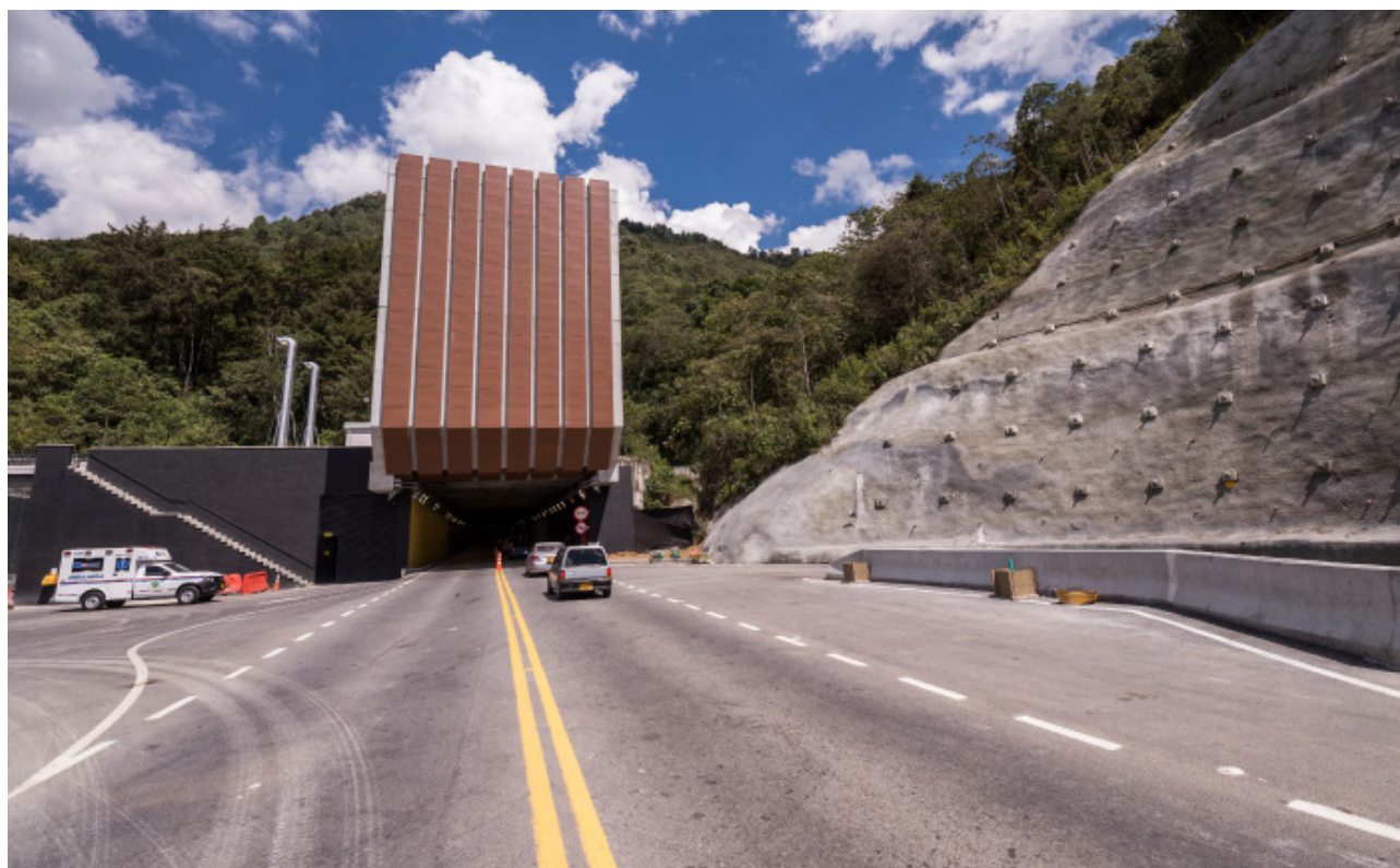
Túnel de Oriente Antioquia
