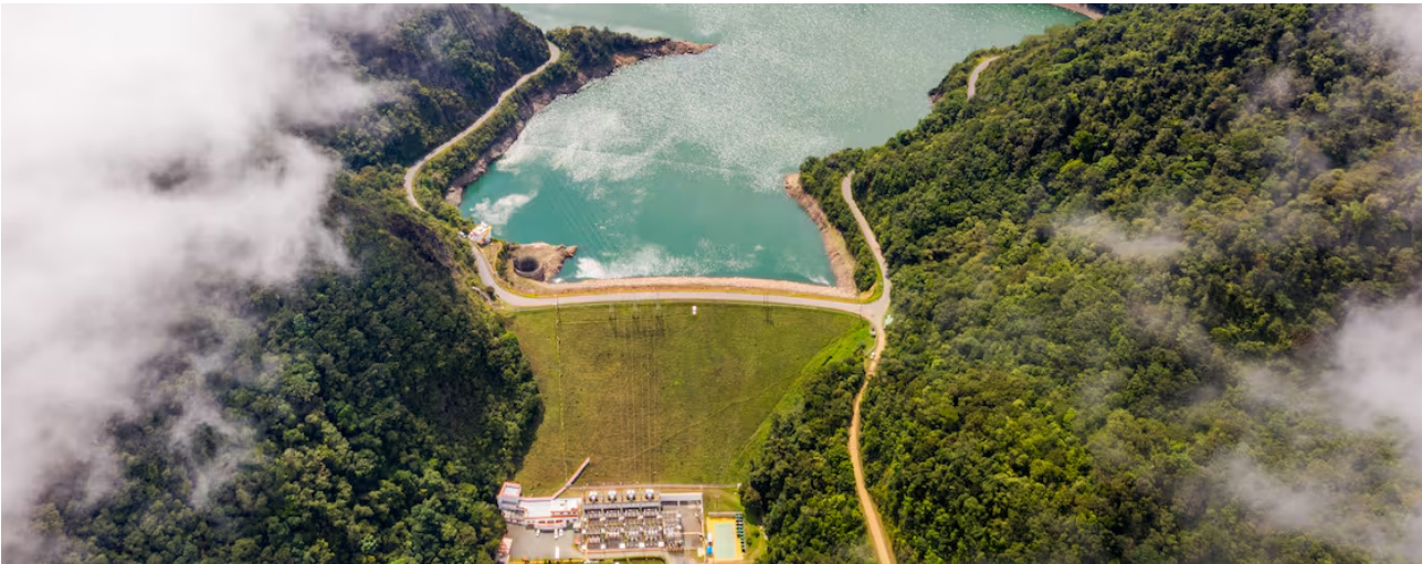
Celsia hidroeléctrica Calima Valle del Cauca
