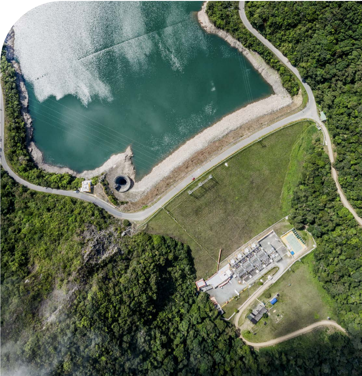
Central Hidroeléctrica Calima, Celsia, Valle del Cauca
