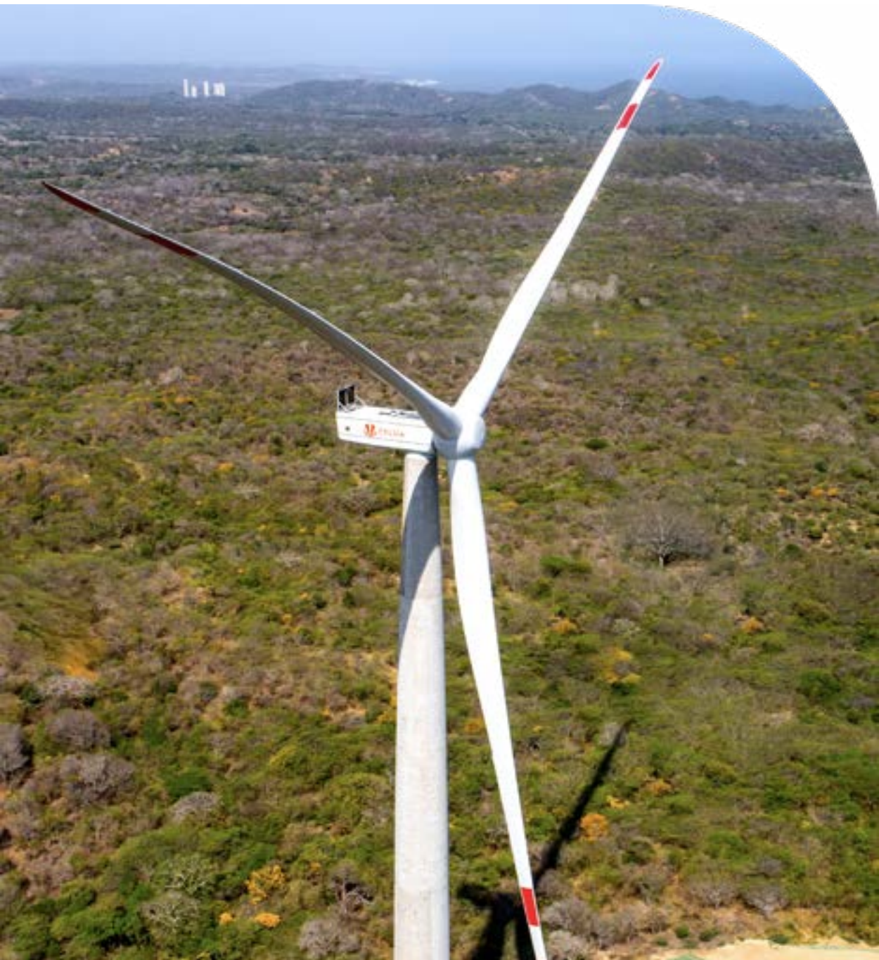
Parque Eólico Carreto, Celsia, Atlántico
