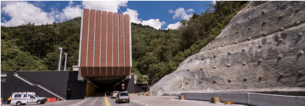
Túnel de Oriente Antioquia
