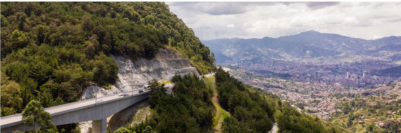
Concesión Túnel Aburrá Oriente Antioquia
