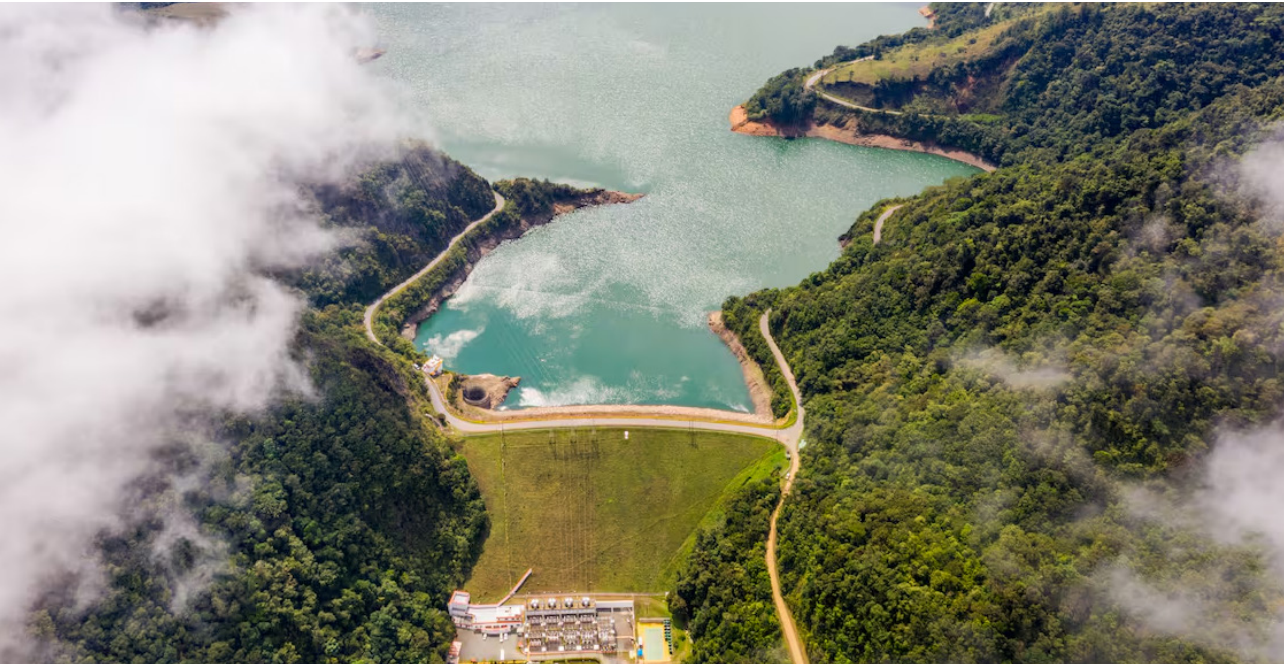
Celsia Hidroeléctrica Calima Valle del Cauca
