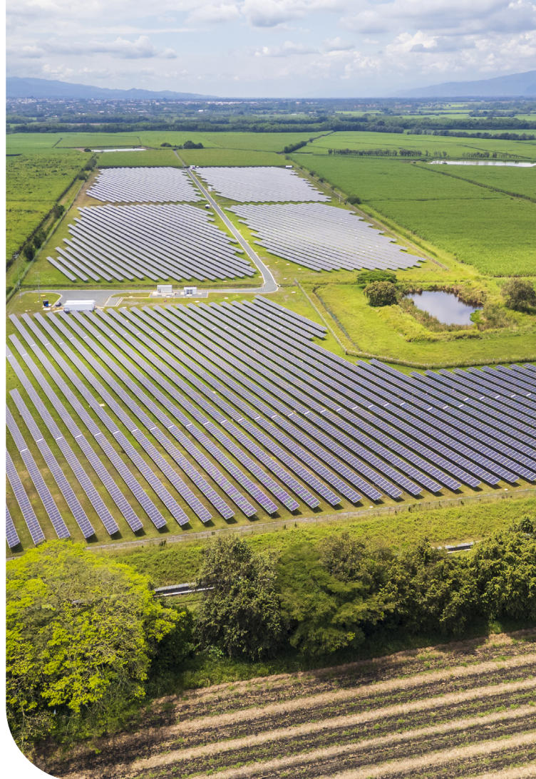
Celsia Solar Andalucía, Valle del Cauca
