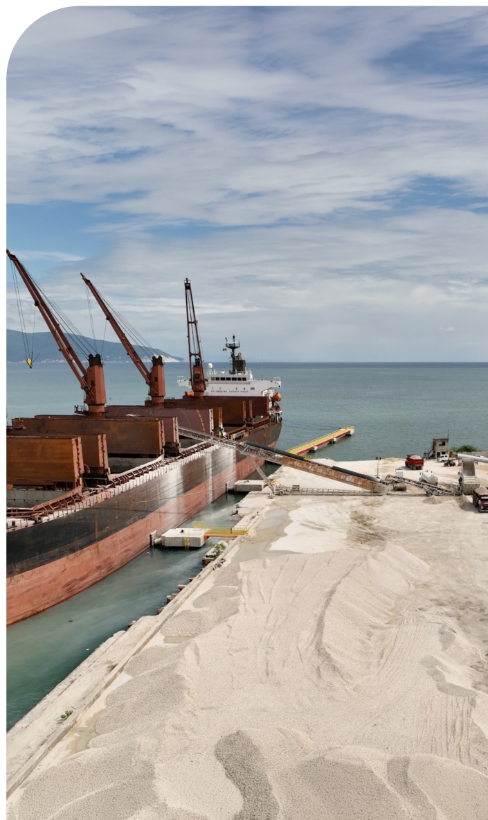
Planta de agregados Argos, República Dominicana
