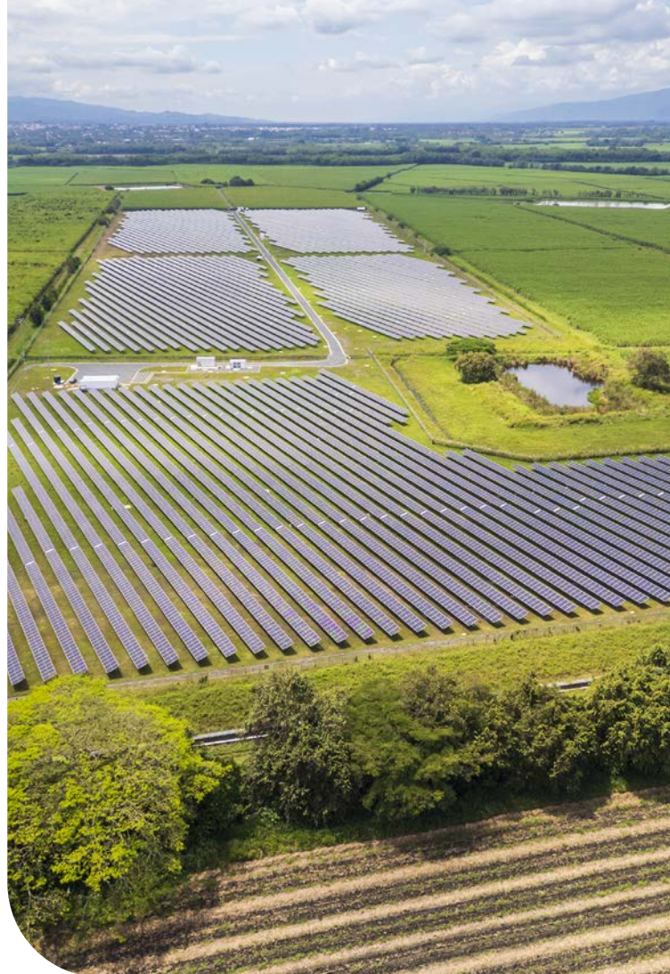
Celsia Solar Andalucía, Valle del Cauca
