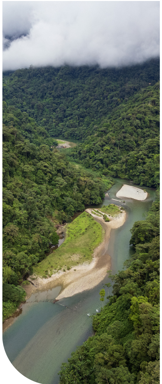
Hidroeléctrica Anchicayá, Celsia, Valle del Cauca
