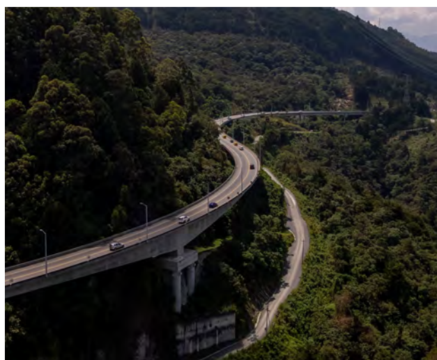
Túnel de Oriente Antioquia
