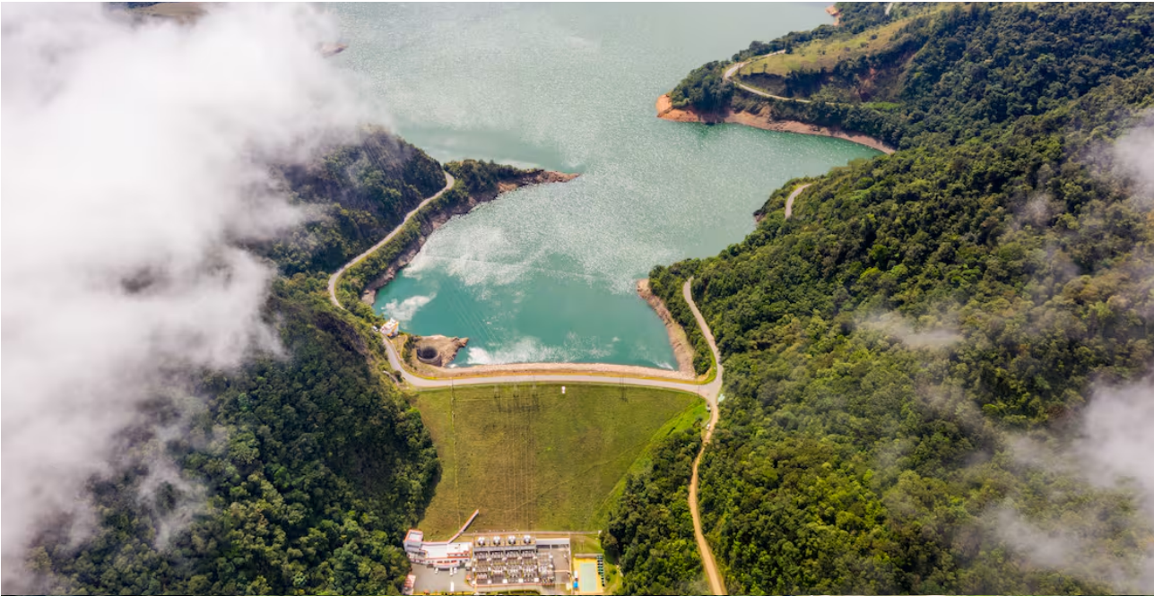
Celsia Hidroeléctrica Calima Valle del Cauca
