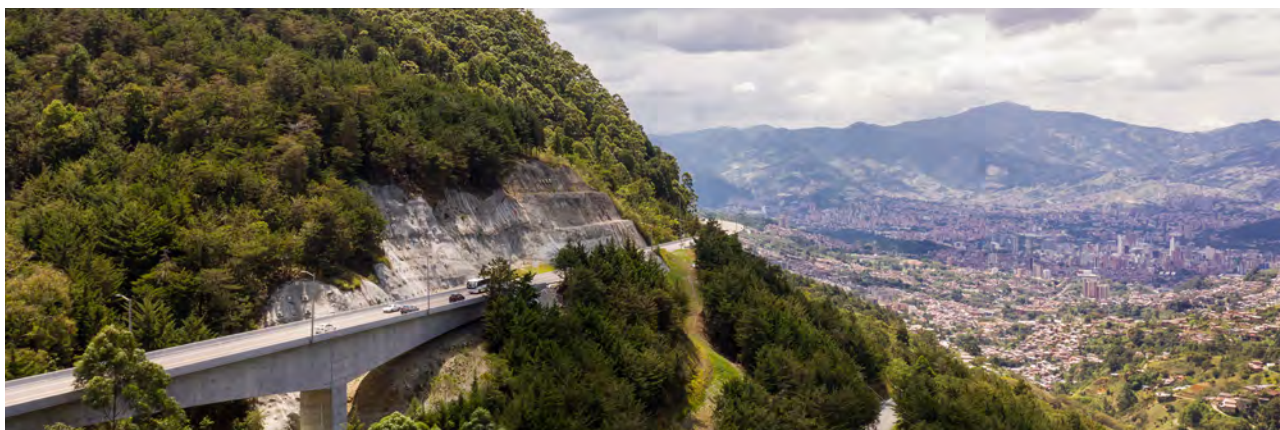
Concesión Túnel Aburrá Oriente Antioquia
