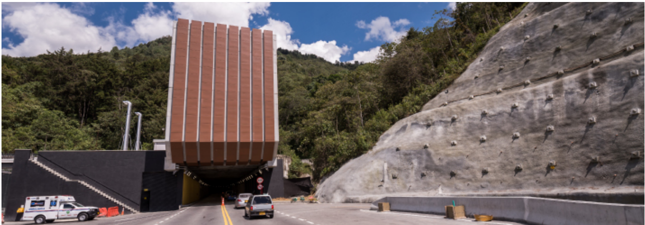
Túnel de Oriente Antioquia
