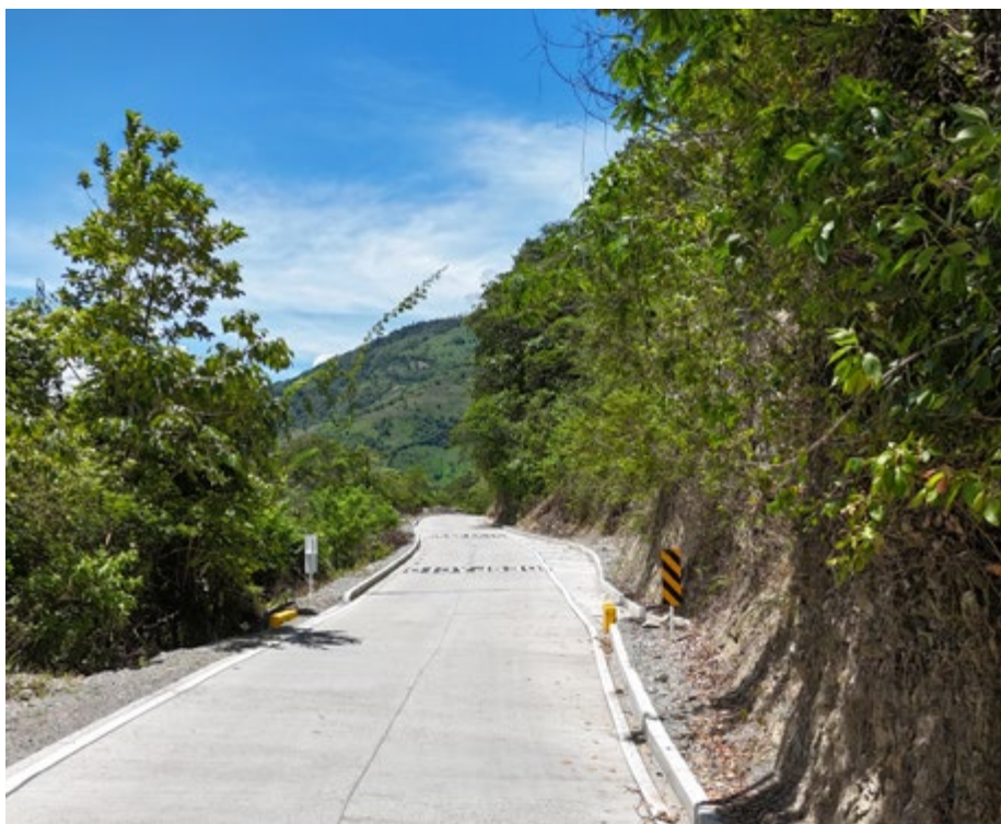
↑ Vía Dabeiba de Obras por Impuestos en Colombia
