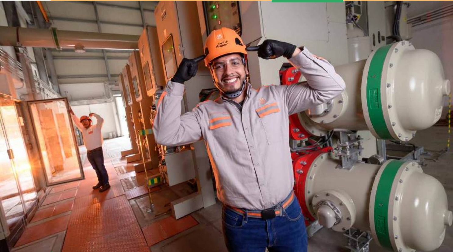
Colaboradores Subestación Vijes, Valle del Cauca.
