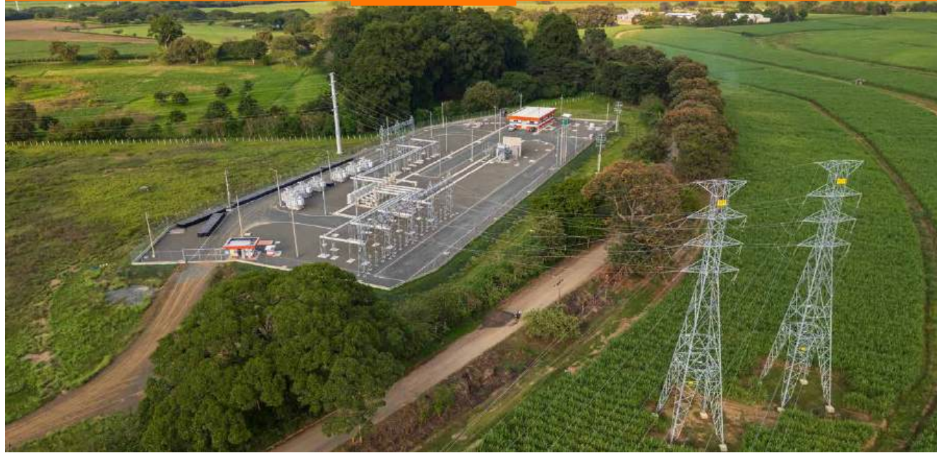
Subestacion Estambul, Palmira.
