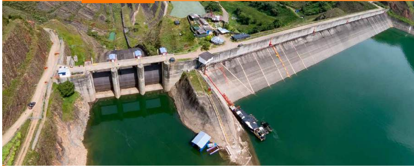
Central hidroeléctrica Salvajina, Cauca
