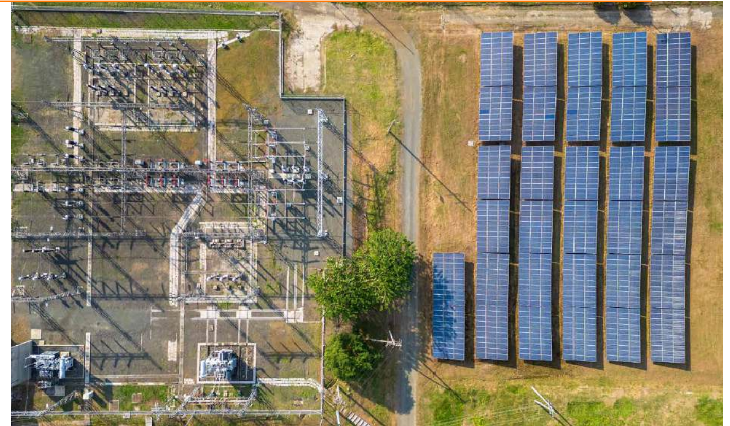
Granja solar Celsia Yumbo, Valle del Cauca
