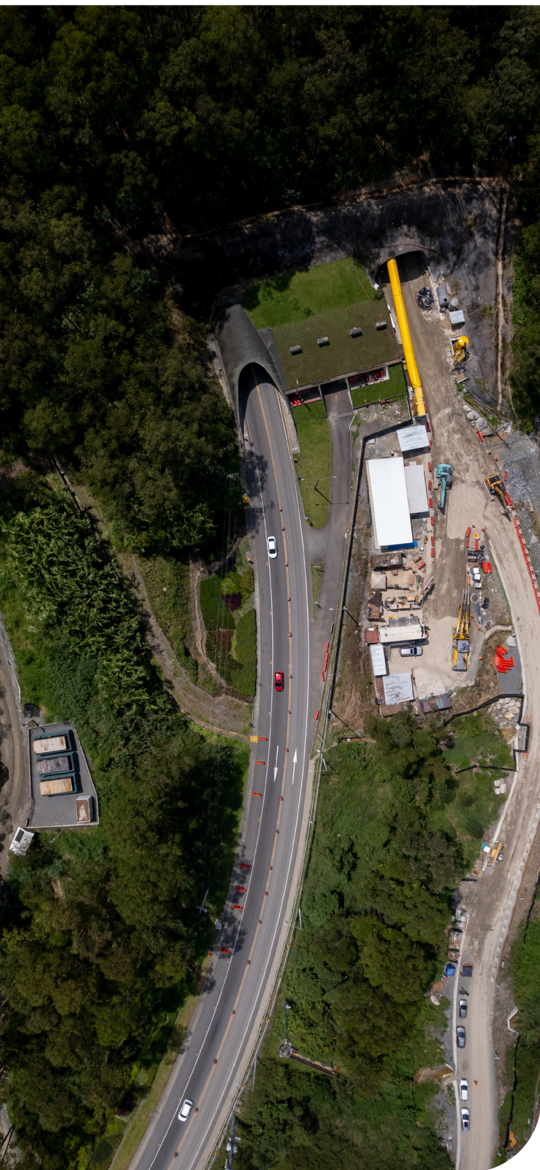
Construcción de la segunda etapa del Túnel de Oriente, Antioquia
