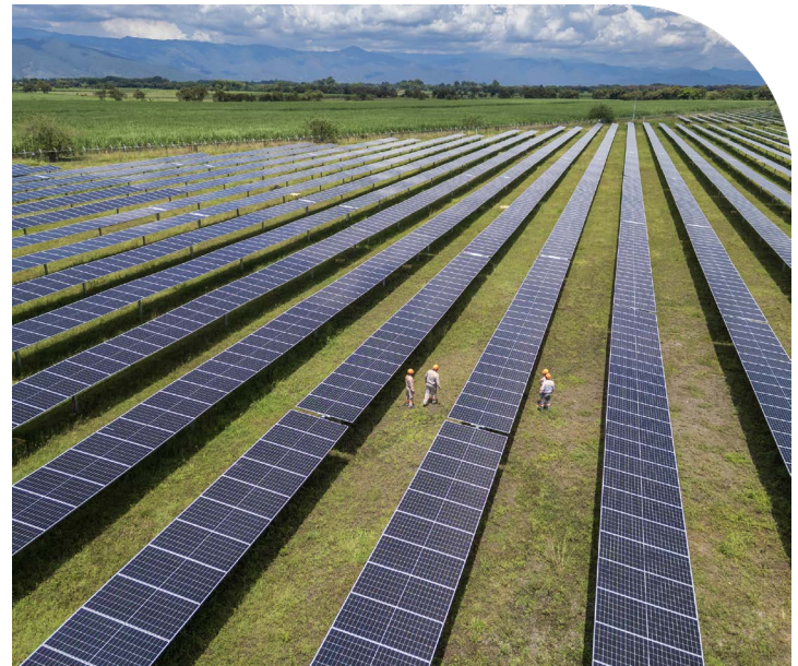
Celsia Solar Andalucía, Valle del Cauca
