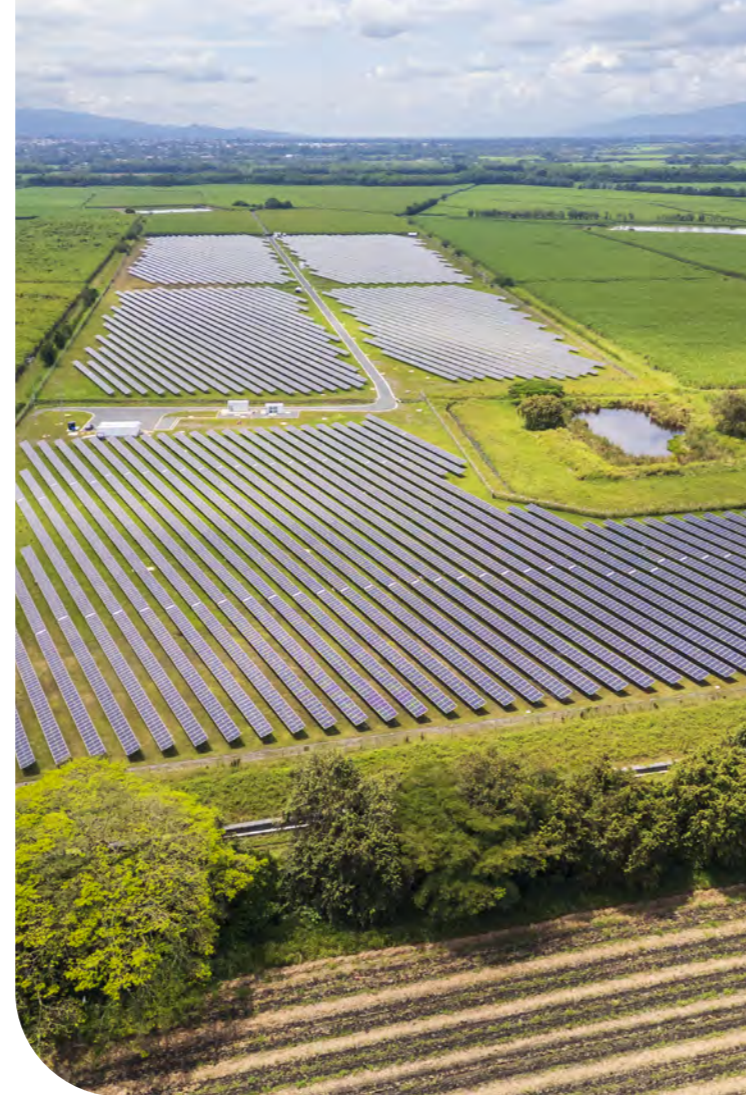
Celsia Solar Andalucía, Valle del Cauca
