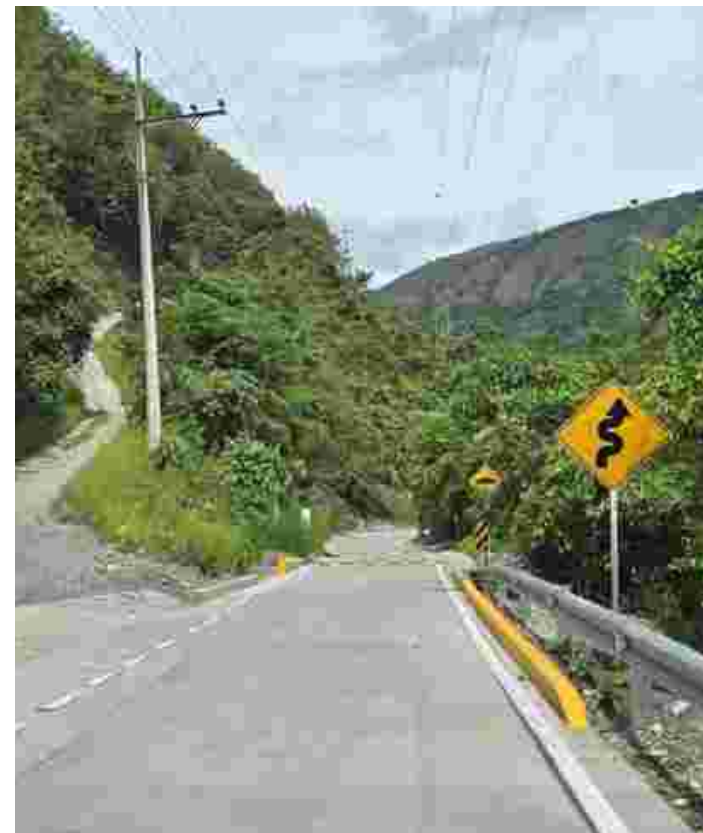
Tramo 2 Dabeiba – Camparrusia, proyecto Obras por Impuestos
