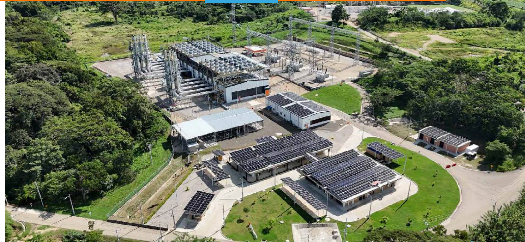
El Tesorito solar rooftop.
