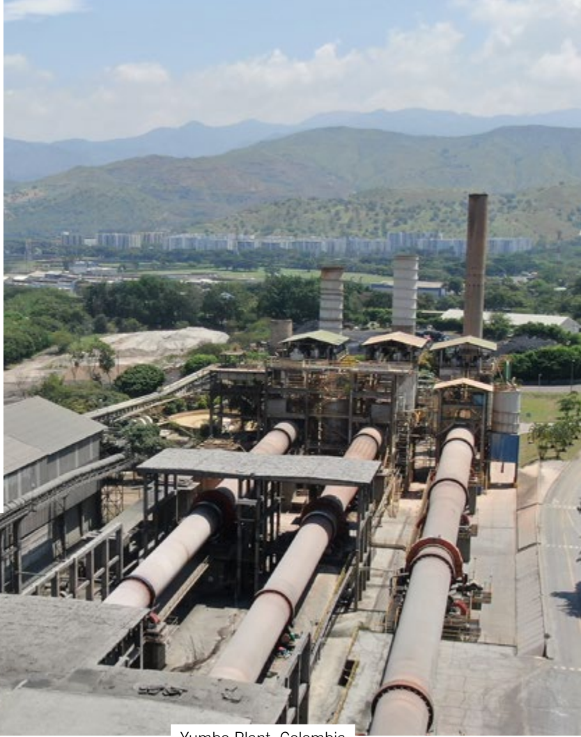
Yumbo Plant, Colombia
