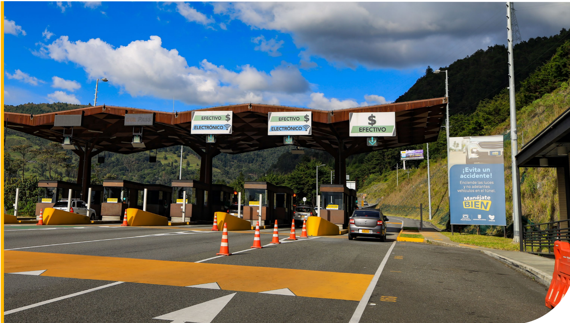
Túnel de Aburrá de Oriente
