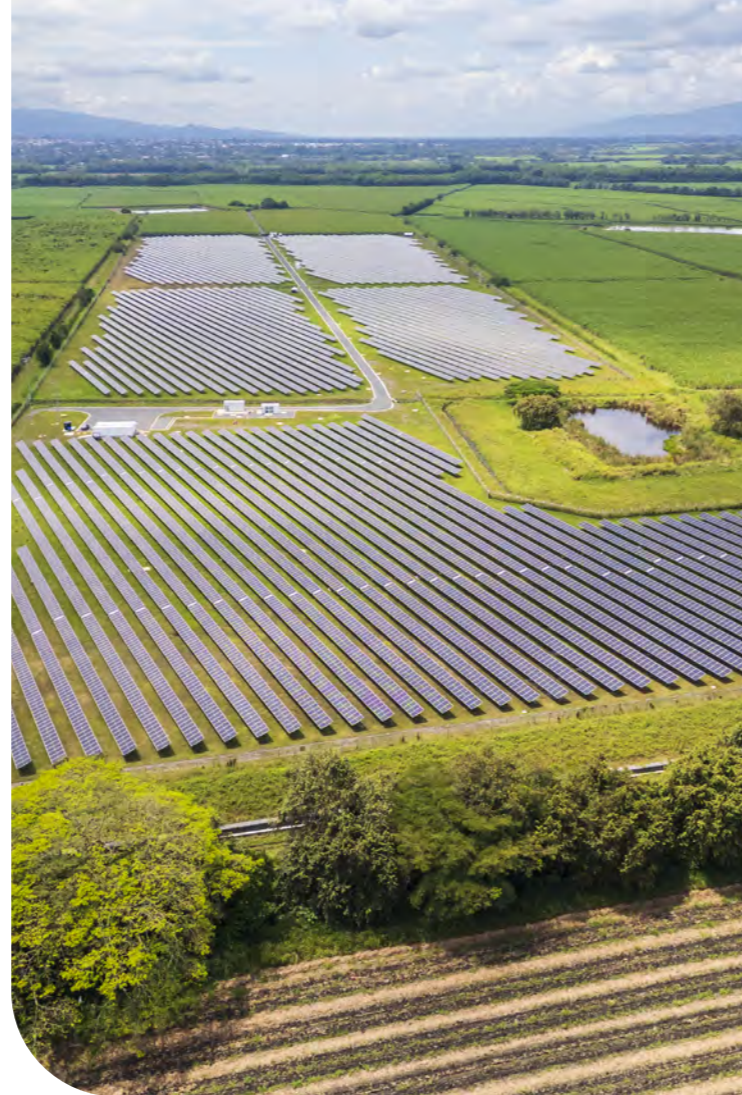
Celsia Solar Andalucía, Valle del Cauca
