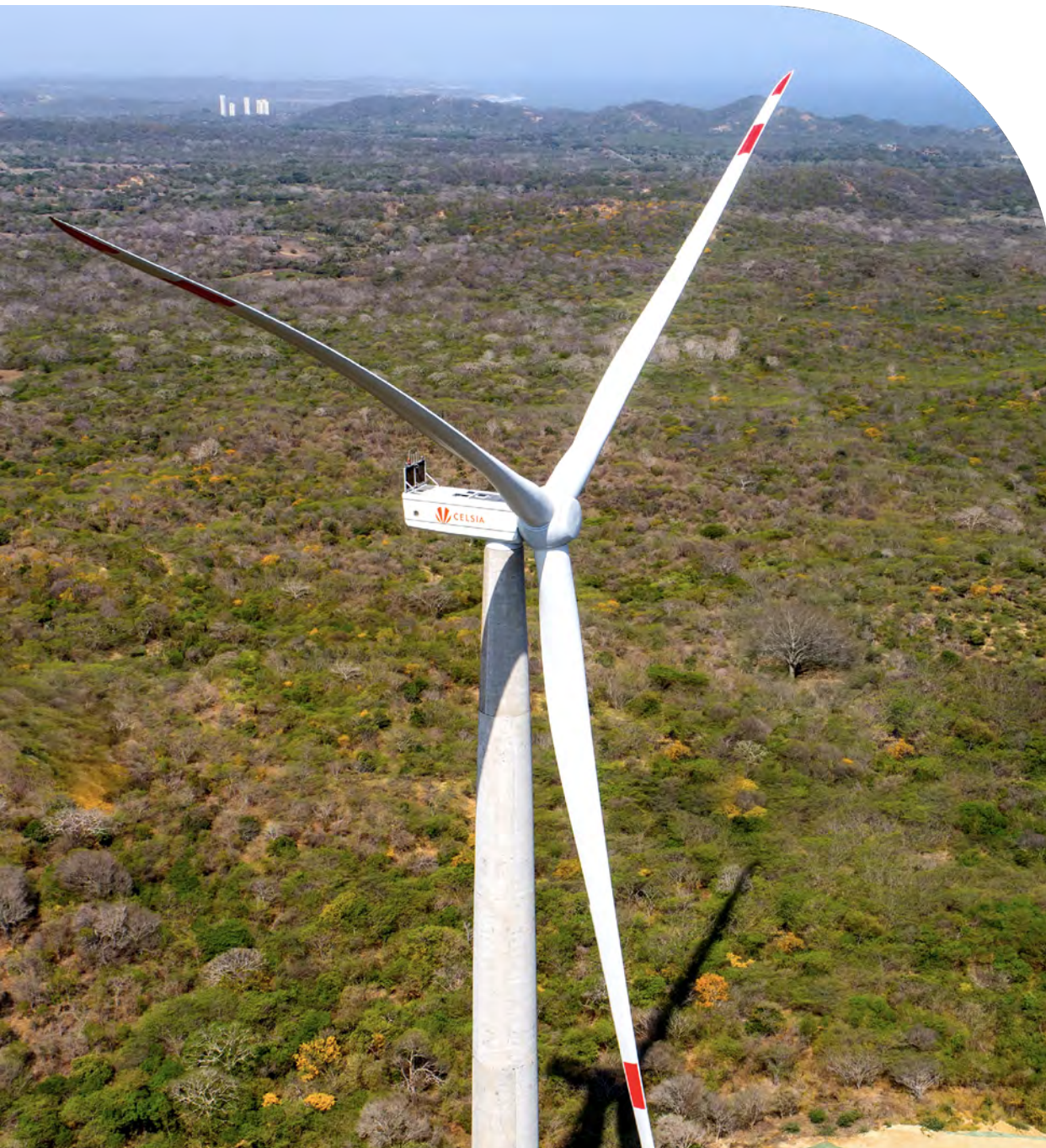
Parque Eólico Carreto, Celsia, Atlántico
