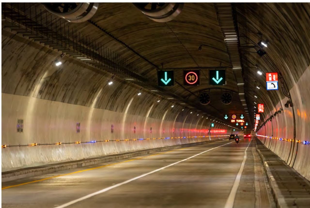
Túnel de Oriente, Antioquia
